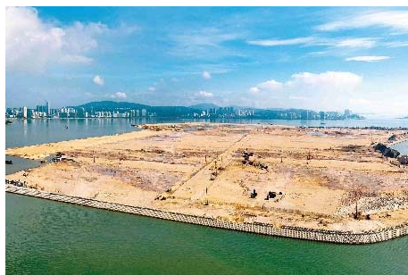
港珠澳大桥西人工岛吹填工程
