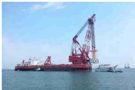
12000吨自航全回转起重船实施吊装
