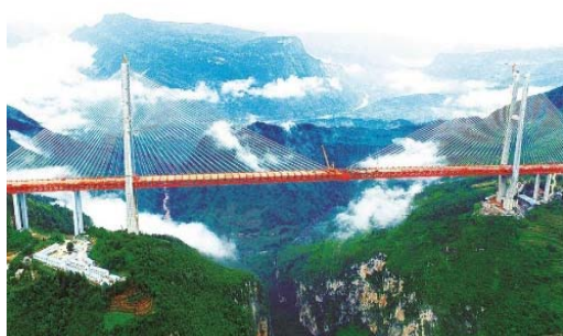
北盘江大桥-世界第一高桥
