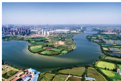
武汉东西湖区径河清淤护岸工程
